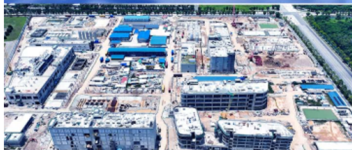
Tuas Site Singapore
